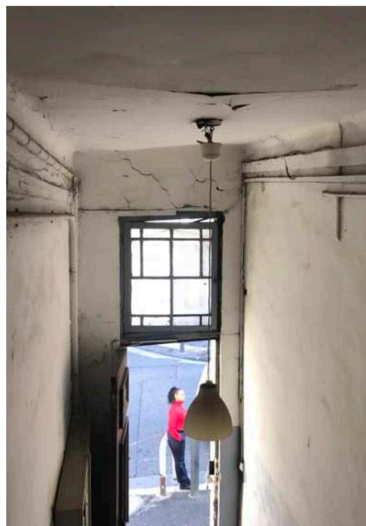
Fissure traversante sur le linteau de la porte d'entrée
