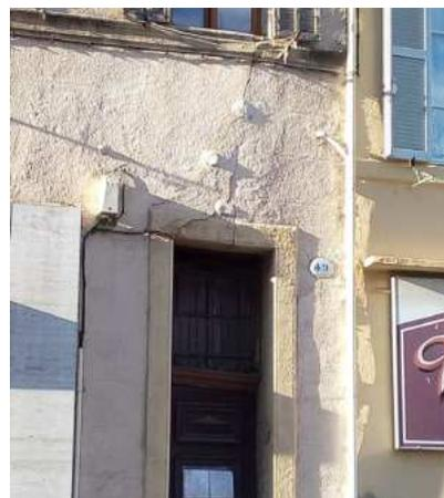
Fissure à 45° sur allèges de fenêtre R+1 et déformation du linteau
