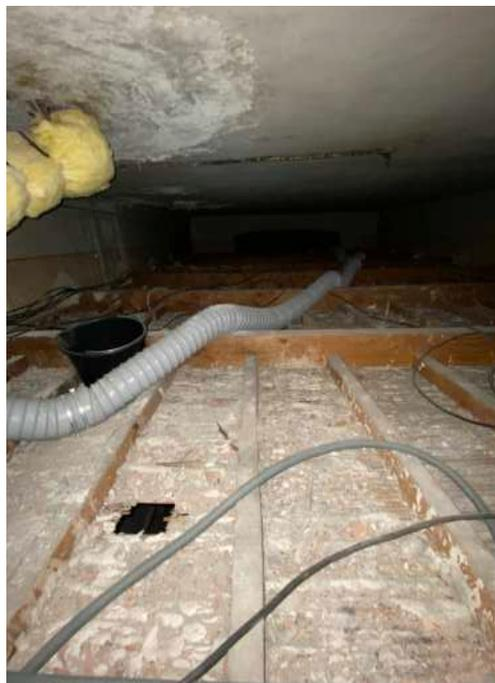
Présence de calcite sur faux-plafond canisse, traces de dégât des eaux
